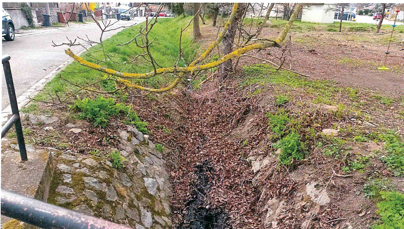
13) ) Konec úseku - výtok ze zatrubnění opevněný dlažbou (po proudu)
