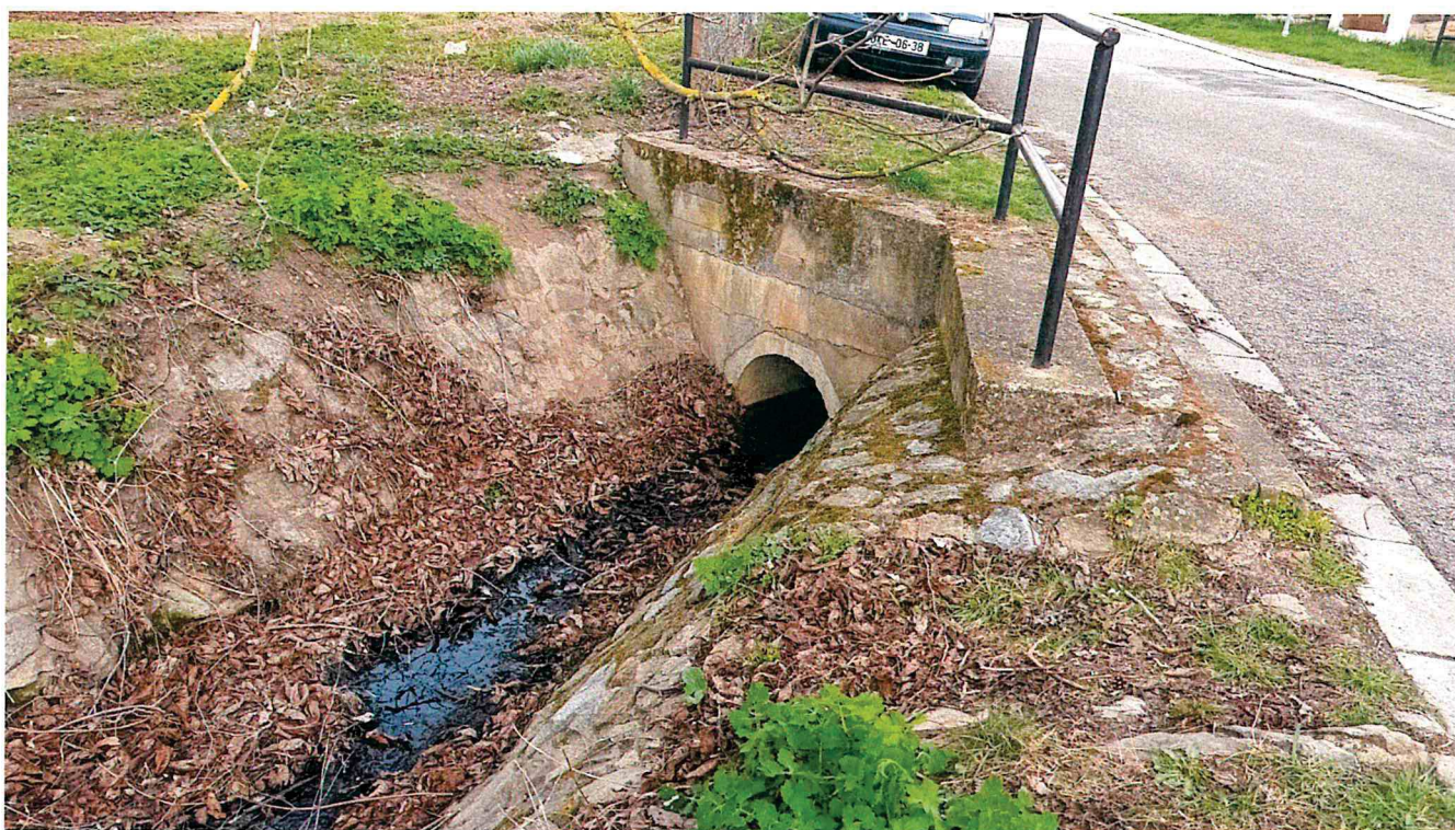
14) Konec úseku - výtok ze zatrubnění opevněný dlažbou (proti proudu)
